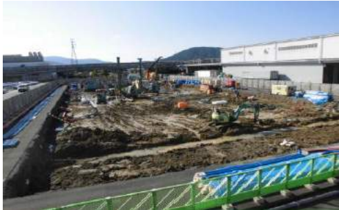
↑深さ100mにボーリング熱交換器設置(100本)
